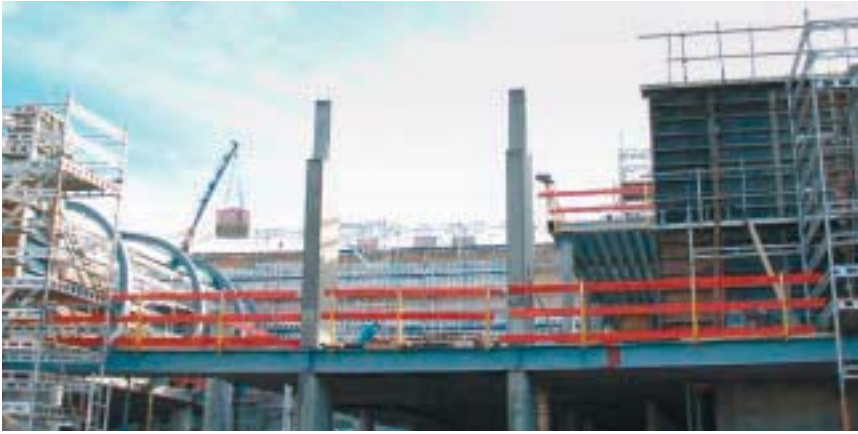
Arbeidet med nytt studentsenter ved Universitetet i Bergen ble startet i mars 2005. Bygget skal stå ferdig i januar 2007, ifølge Statsbygg.
